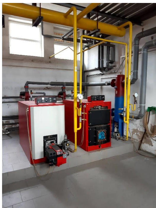
Rekonstrukce kotelny červen až srpen 2021
